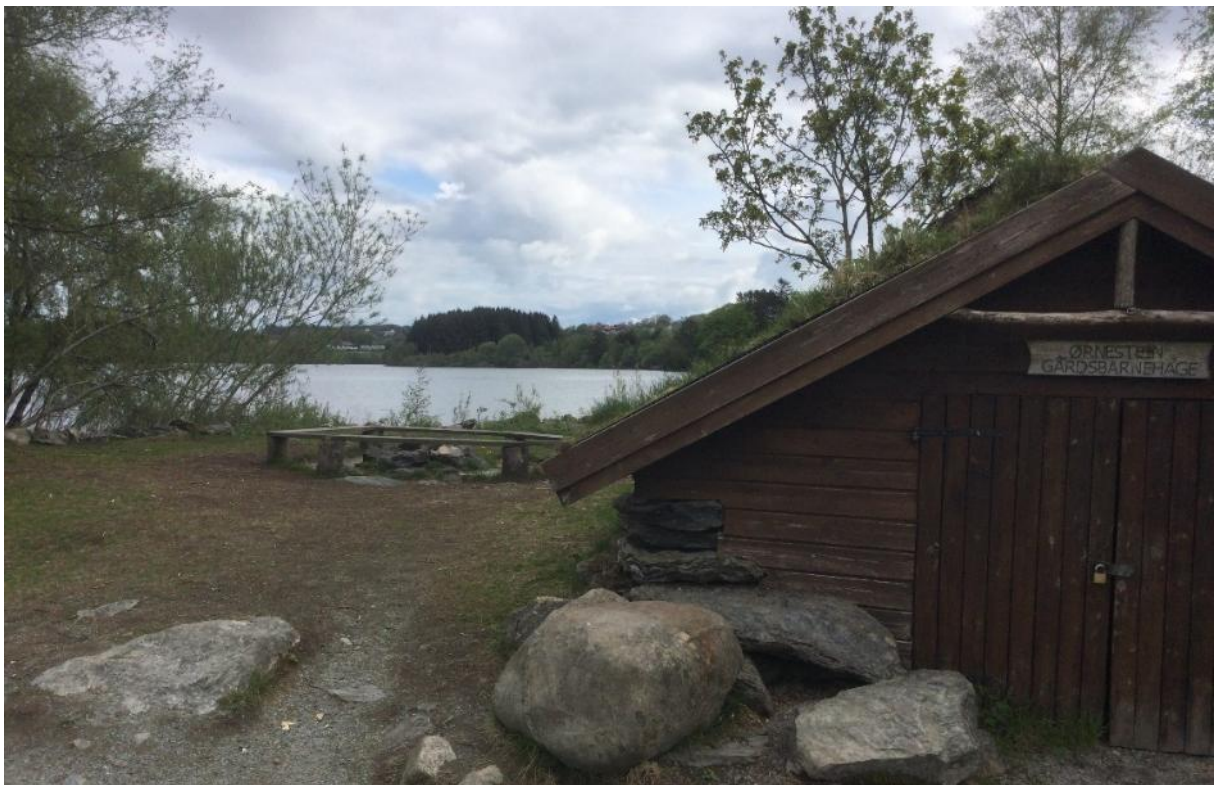
Figur 5-5. Båthuset til Ørnestein Gårdsbarnehage ligger i Ragbakken friareal i kanten av Stora Stokkavatnet. Foto hentet fra Torvik og Røst 2021.
